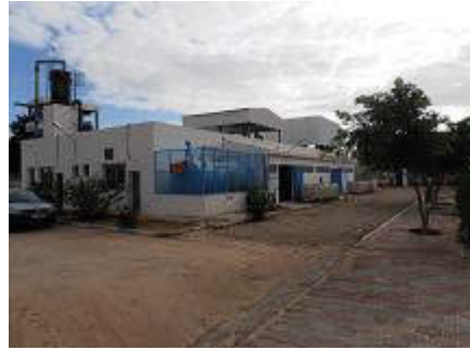
Station de dessalement de Kerkennah
